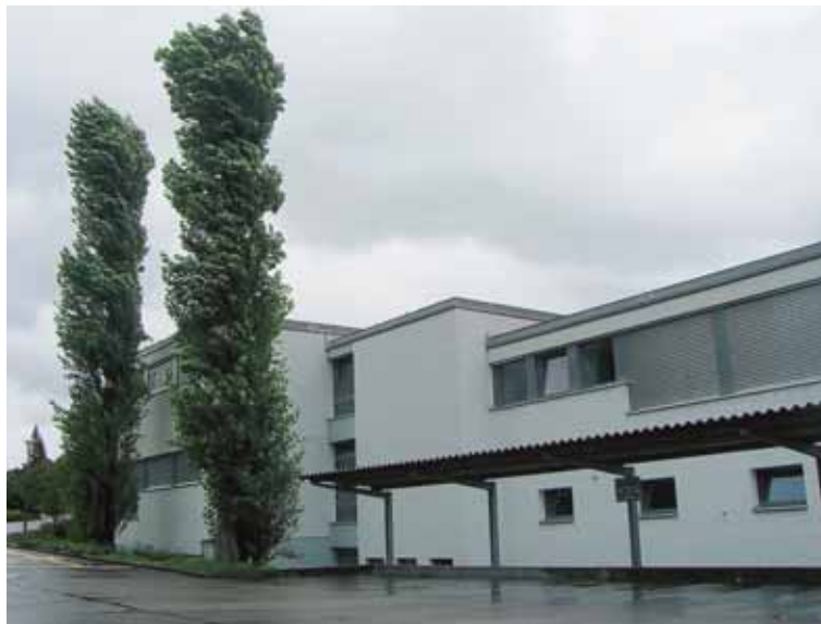
Dunkle Wolken über der sanierten Schulanlage «Sunnerain»: Wer bezahlt diese Fenster? (ti)
