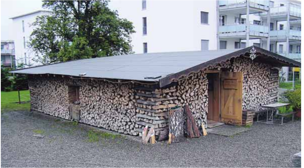
Das schumucke «Holzhüsli», kurz vor dem Abbruch. (Bilder: Alfred Wepfer)
