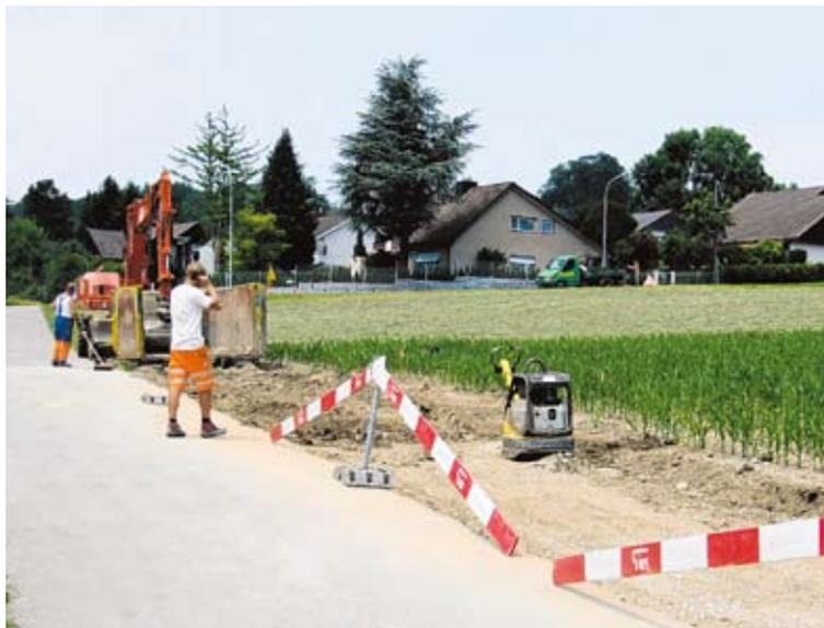
**Bereits wieder zugedeckt: An diesem Strassenstück war die Kanalisationsleitung falsch angeschlossen worden. (mo)**
