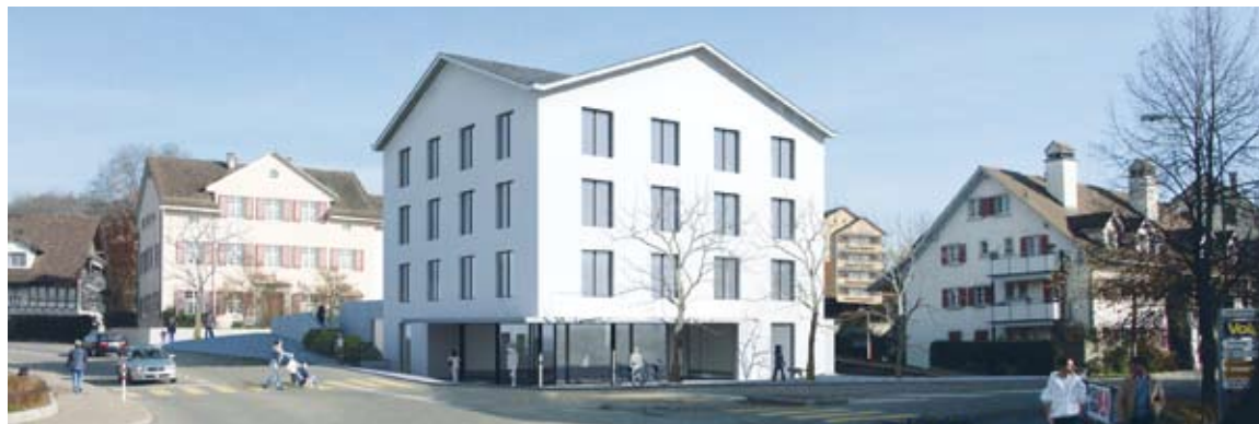
Mit dem Neubau der Gemeinde in Zusammenarbeit mit der reformierten Kirchgemeinde Bassersdorf-Nürensdorf (das weisse Gebäude Bildmitte) wird sich die Zentrumszone beim Lichtsignal ab Herbst 2012 in zeitgemässer Modernität präsentieren. (zvg)
