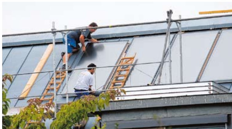
In den vergangenen Wochen wurden insgesamt 72 Quadratmeter Solarpannele auf dem Dach des Pflegezentrums Bächli in Bassersdorf montiert, welche das Warmwasser produzieren helfen.
