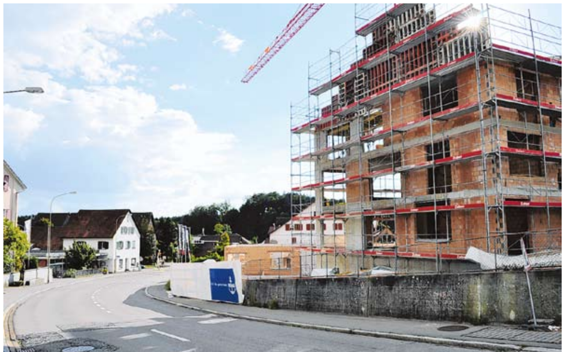
Rechts im Bild entsteht eines der Mehrfamilienhäuser des Alterszentrums; das weisse Haus vorne Mitte links (ehemaliges Volg-Gebäude) wird demnächst abgebrochen um dem neuen Zentrumsgebäude Platz zu machen. (sst)
