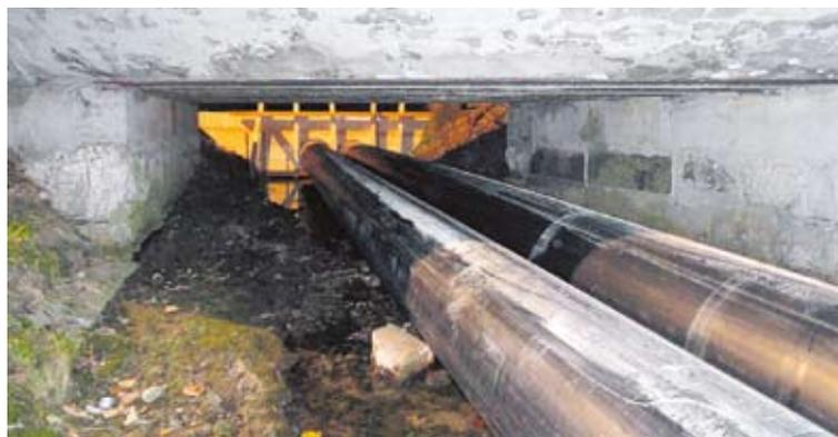
*Das Wasser des Auenbaches musste während der Bauarbeiten durch Rohre geleitet werden.*
