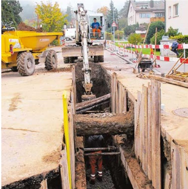
**Über vier Meter musste in die Tiefe gegraben werden um die alte Kanalisationsröhre durch eine neue ersetzen zu können. (mp)**
