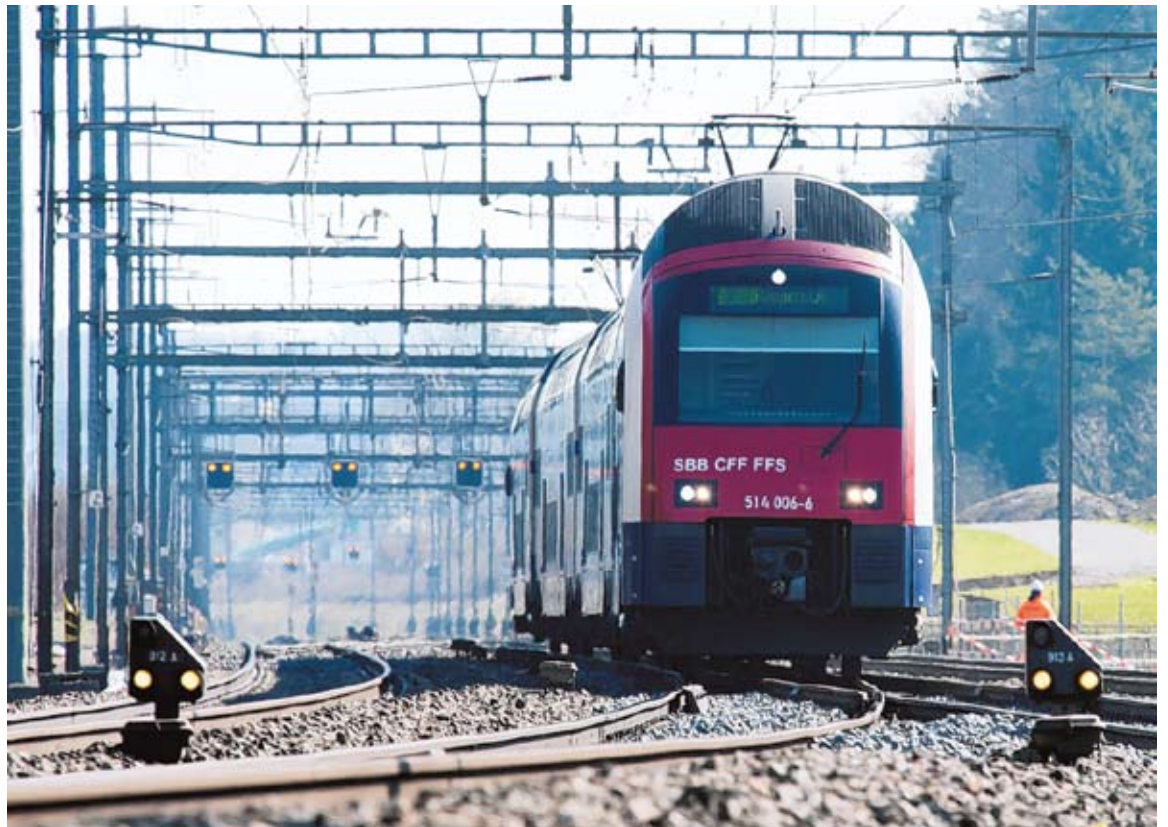
Ab Bahnverzweigung Hürlistein werden aus vorher drei Bahngeleisen (von Effretikon kommend) deren vier; zwei Geleise (im Bild vorne links) bewältigen den Zugverkehr von und nach Bassersdorf. (Bild: Mano Reichling)
